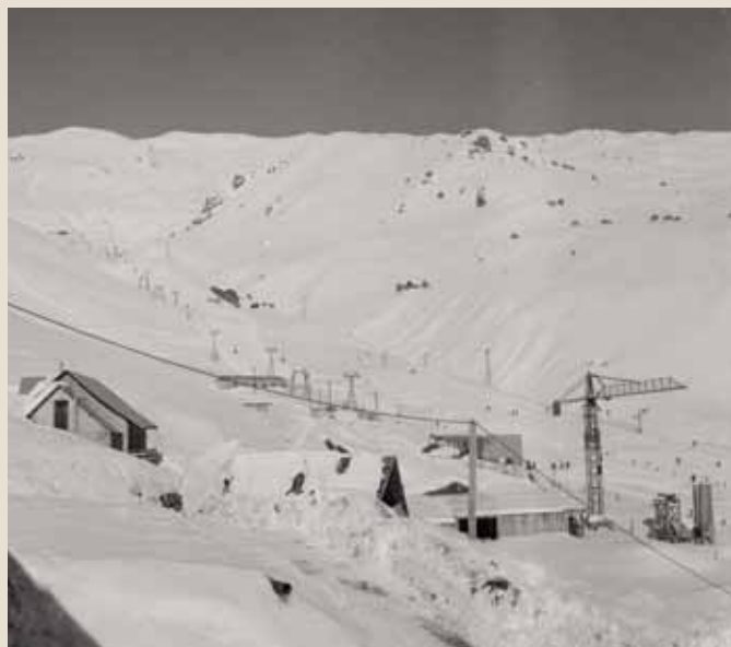
EN 1963, des bâtiments en construction à côté des granges à foin de Merlette. (Photo Henri Baranger / ADHA)
