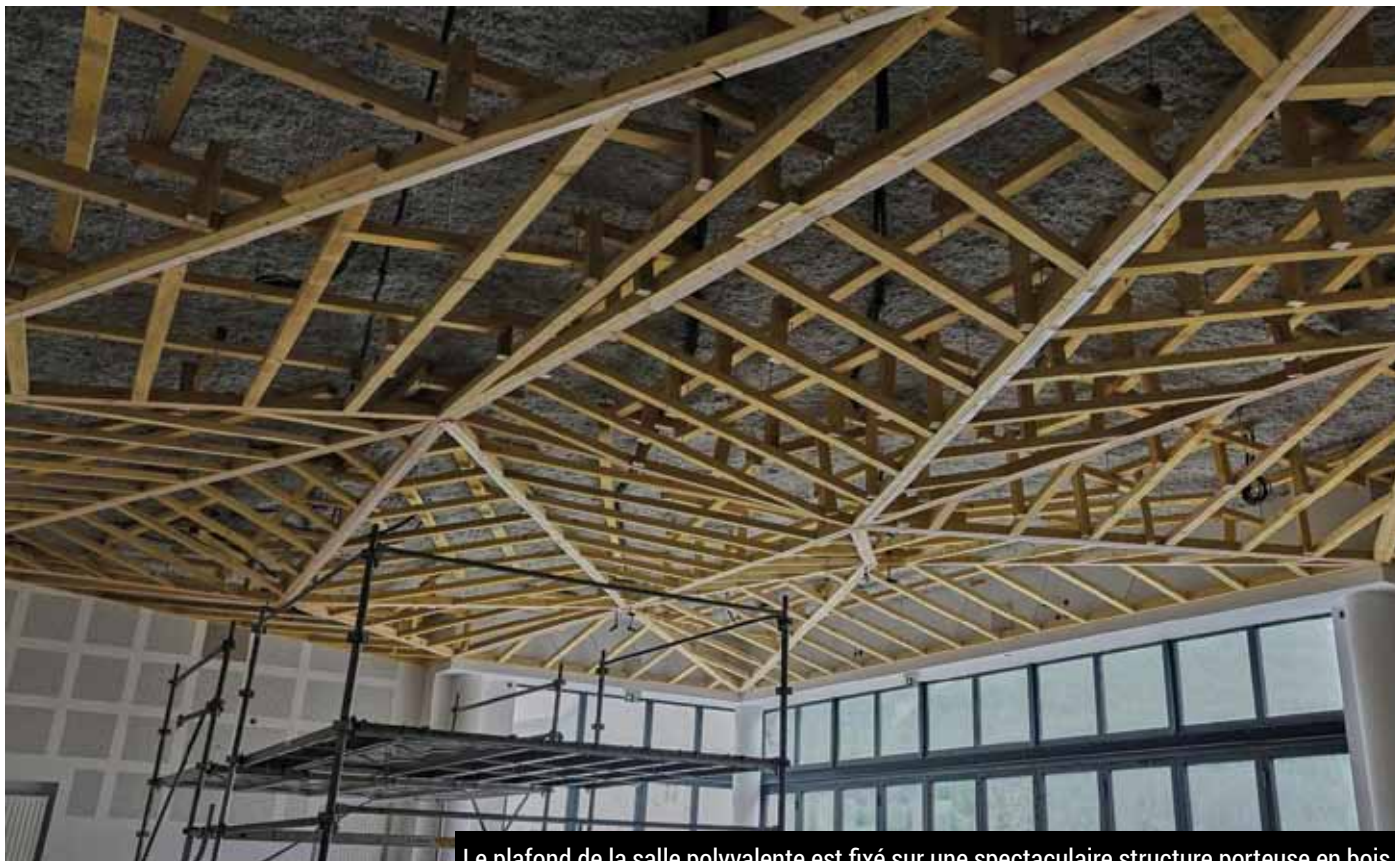
Le plafond de la salle polyvalente est fixé sur une spectaculaire structure porteuse en bois.
