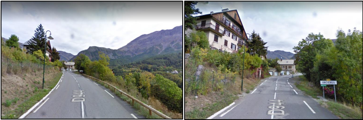
Entrée dans le village d'Orcières Source : Googlemaps - street view
