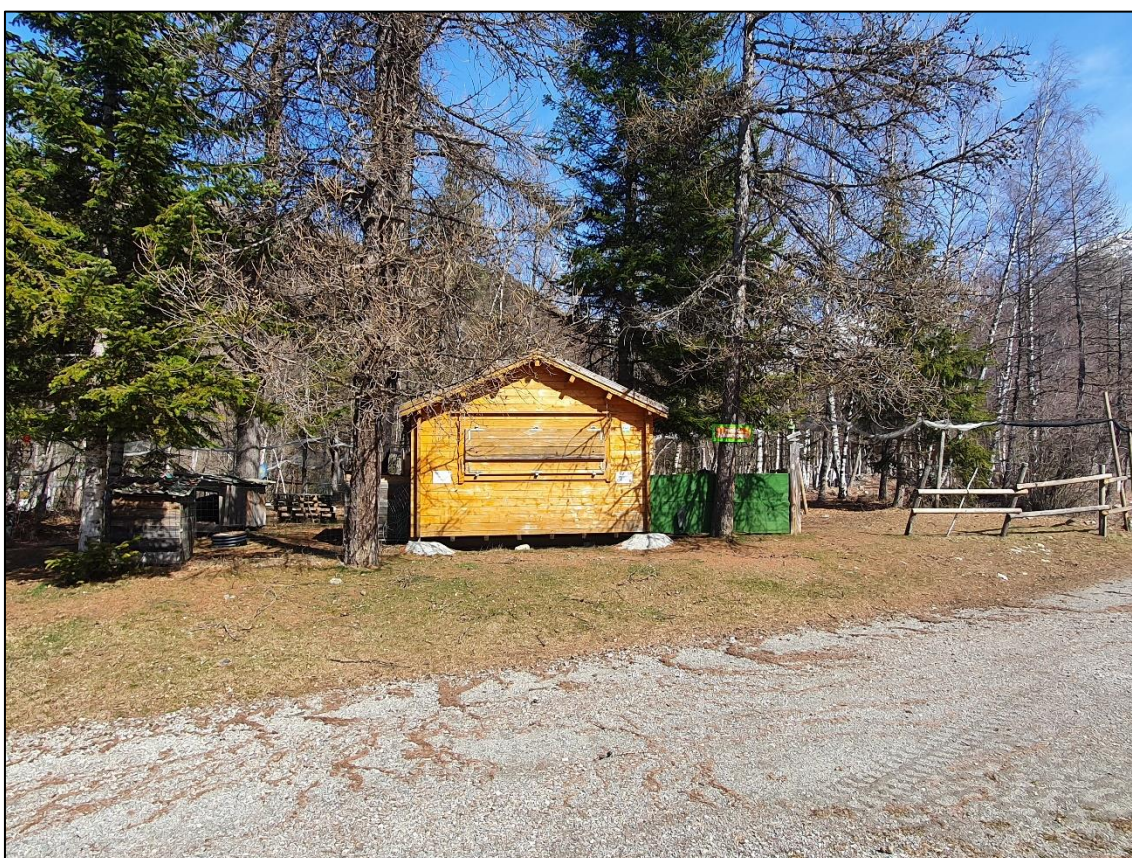
Photographies de la zone de stockage/accueil existante aux abords du plan d'eau
