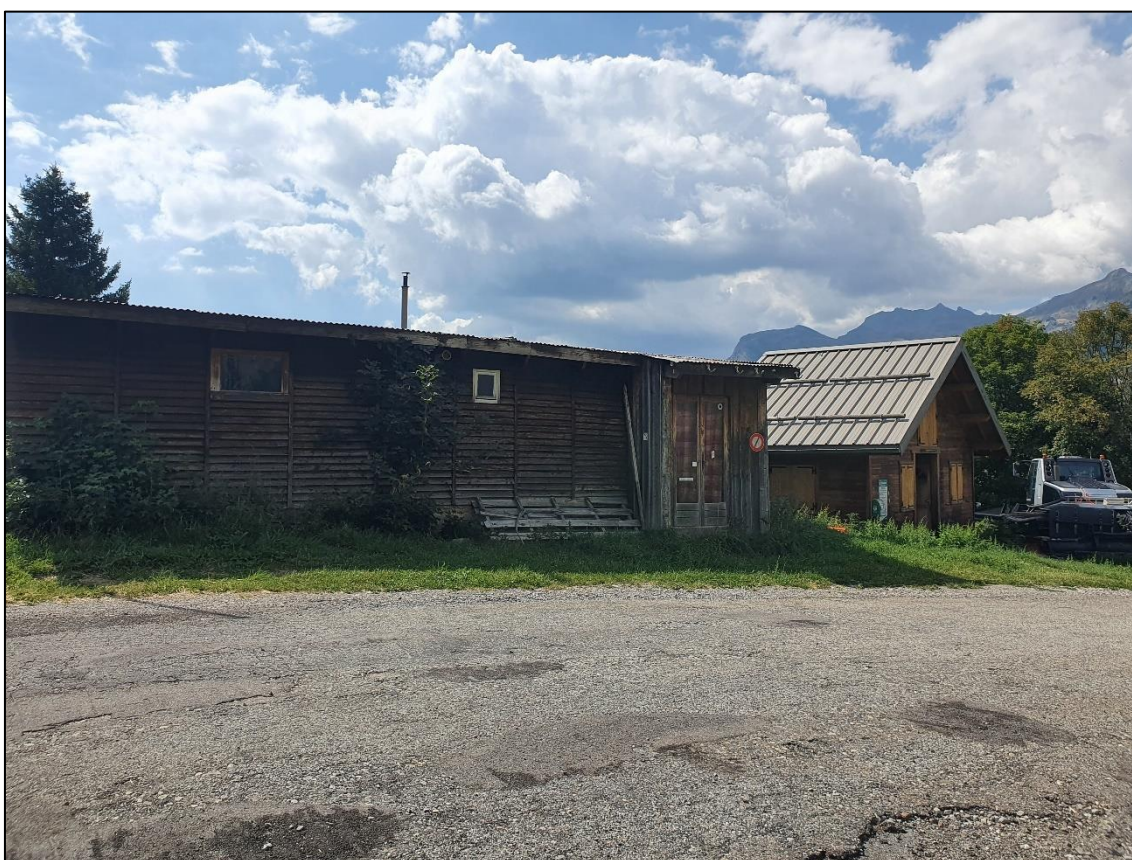
Photographie du bâti existant sur la zone
