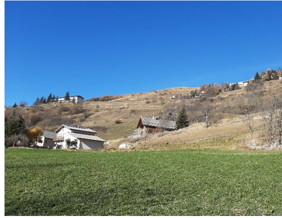
Vue sur les constructions récentes à l'ouest du hameau des Veyers
