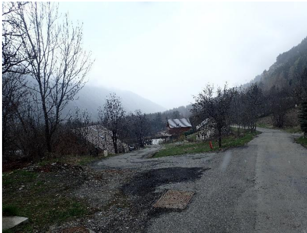
Entrée ouest sur la nouvelle voie de desserte
