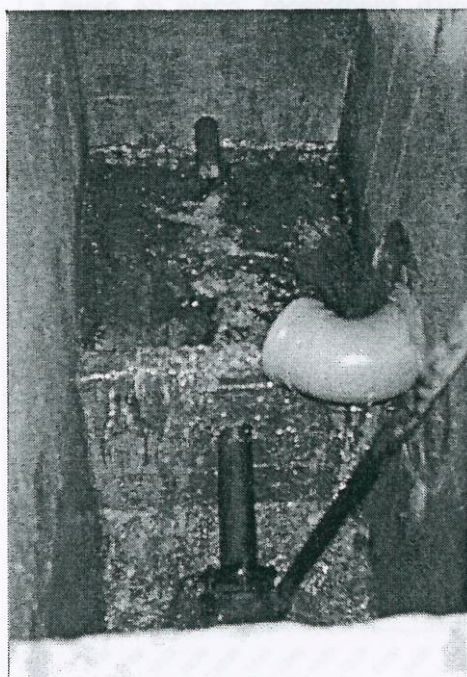
Intérieur du captage
