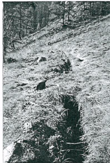
Tranchée réalisée pour le captage de la nouvelle source PB2
