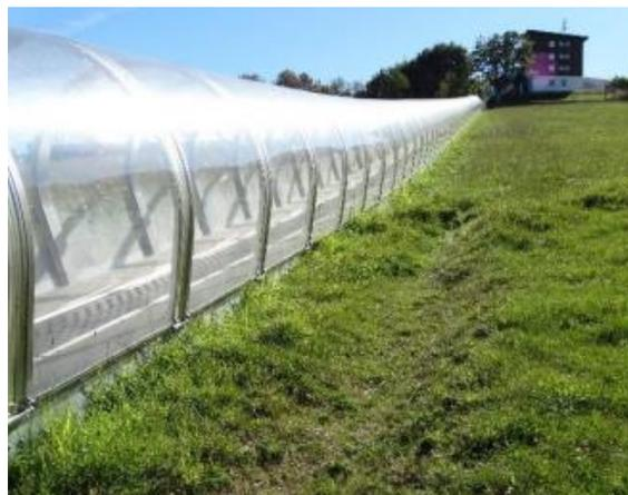
Exemple d'un tapis correctement raccordé au terrain naturel, mais à la couverture réfléchissante
