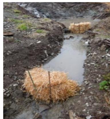
Figure 1 : Exemple d'un système de filtration mis en place lors de terrassements - source : KARUM
