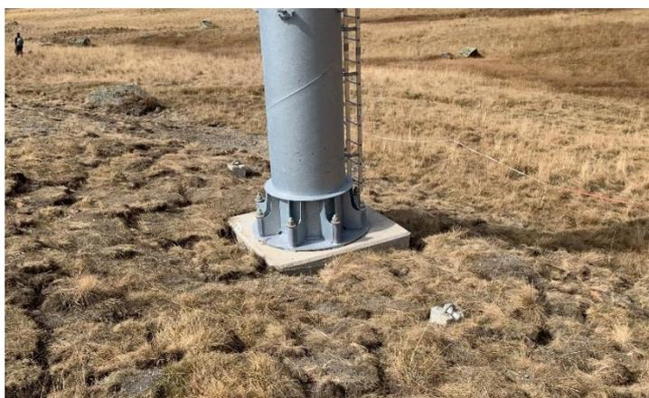
Photographie d'un pylône de télésiège avec étrépage autour du massif béton. Source : KARUM.
