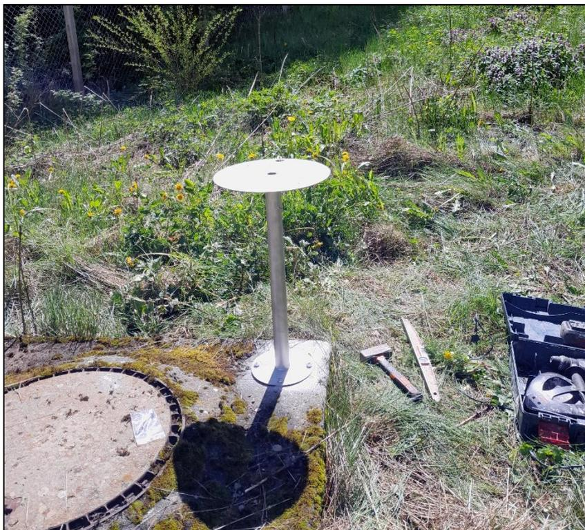
17/05/2024 : Installation du support du pluviomètre et passage des câbles de l'extérieur jusqu'au local des armoires.
