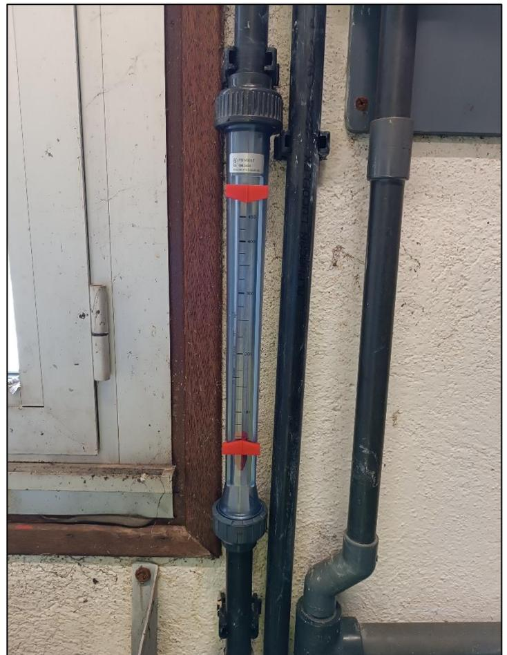
Photo avant/après. Ce dispositif nous permet de savoir exactement quel est le débit de la pompe à polymère.
