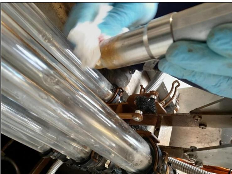
Le vérin pneumatique qui permet le bon raclage / nettoyage du banc UV B est défectueux : prévoir son remplacement.
