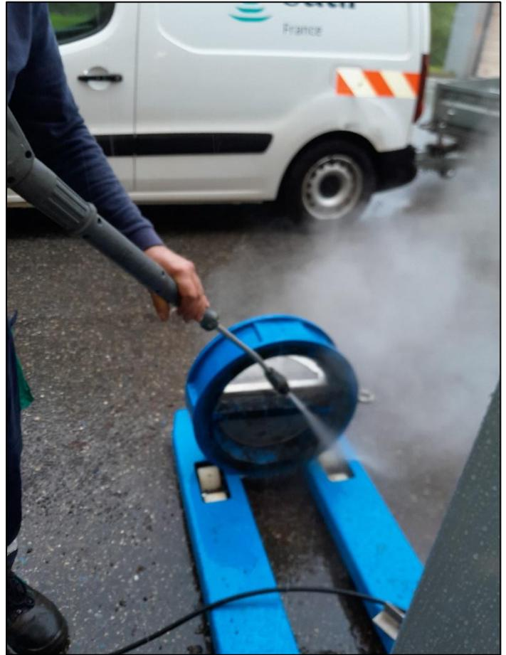
Le clapet n'est pas grippé mais bien encrassé. Nous l'avons donc décapé à la haute pression et à la buse rotative. Il est ressorti en bon état.
