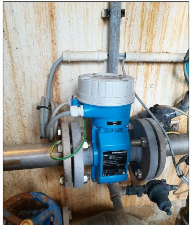
L'équipement est composé d'un débitmètre en ligne sur la conduite d'alimentation de la centrifugeuse ainsi que de son transmetteur avec afficheur, posé en façade d'ouvrage.
