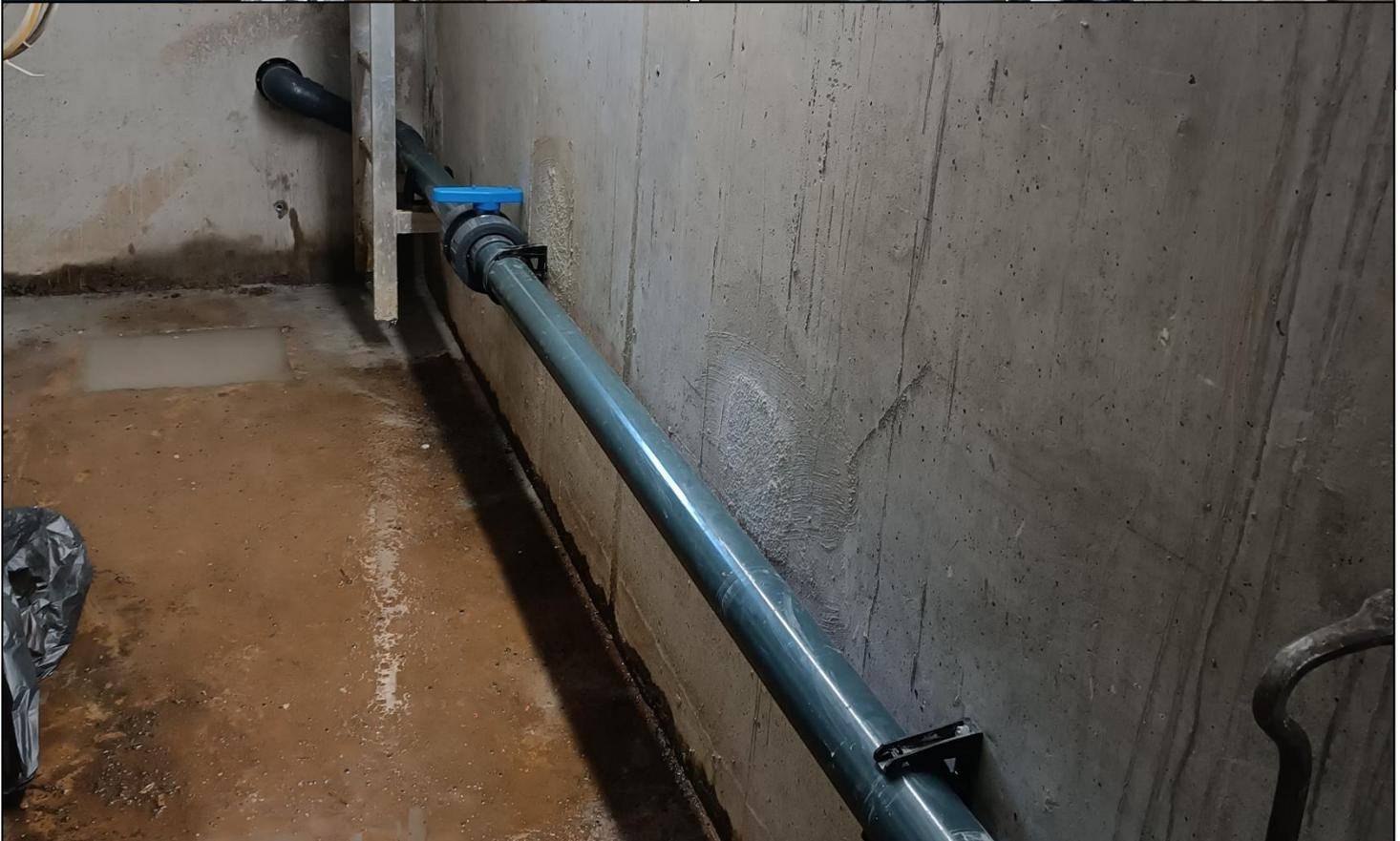
Opération carottage du PR « eaux industrielles » + poses des conduites en PVC d'aspiration et de refoulement alimentant le skid.
