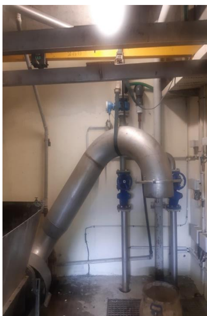
18/08/2021 rupture du pied de l'agitateur bache eaux sales réparation fixation en inox
