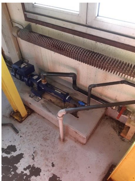
03/06/2021 nettoyage, peinture du local compactage en vue de la mise en place de la presse laveuse
